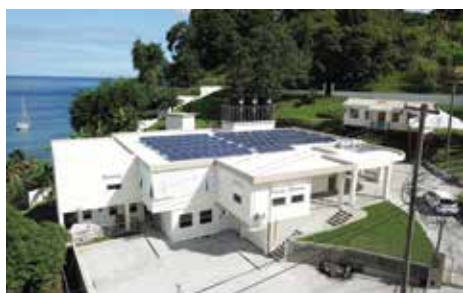
Obras completas de modernización en el Hospital Chateaubelair, San Vicente y las Granadinas, 19 de febrero de 2019.
